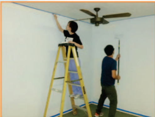
Vệ sinh tường
